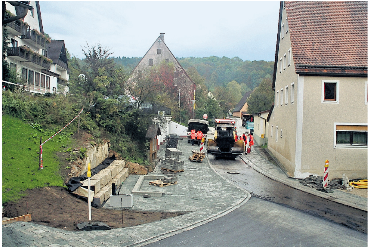
In der Dorfmitte wurde ein altes Gebäude abgerissen. Dort kommt das Buswartehäuschen hin. Fotos: E. Bodendörfer
